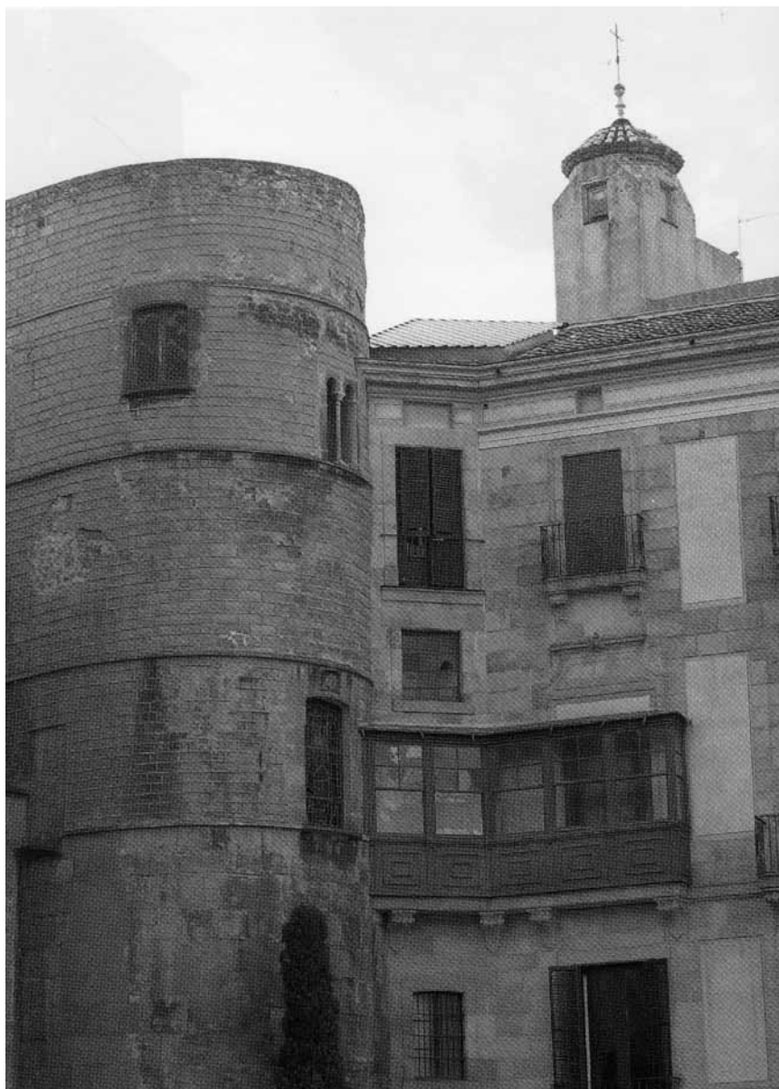
Torres romanes del Palau Episcopal. Segle IV (la interior té l'acabament barroc).
